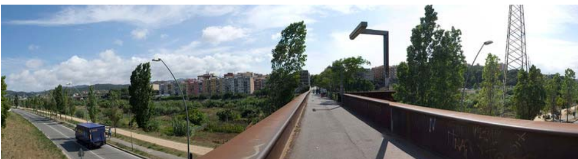
Pont sobre el riu Ripoll entre Ripollet i Cerdanyola. Font: AMB
